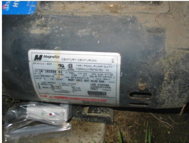
**FIGURE 3. TIME OF USE LOGGER ATTACHED TO POOL PUMP MOTOR HOUSING**
